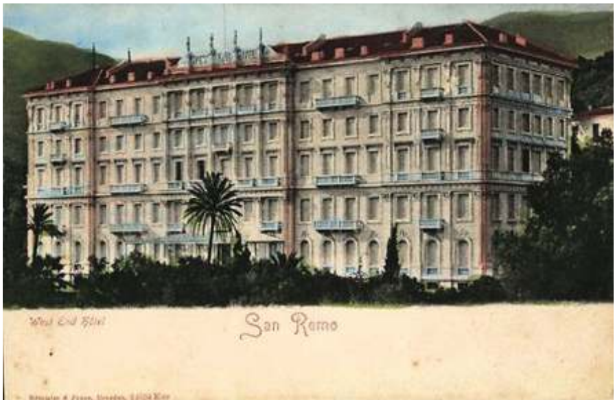
Astoria West End, facciata principale
